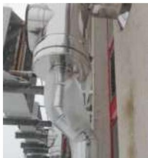
Nell'esempio a lato **sono evidenti, il congelamento della condensa avvenuto nella tubazione di scarico**, il conseguente **blocco dello scarico**, la risalita delle condense e la conseguente fuoriuscita direttamente dal camino.
