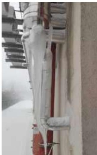
Tutti sanno che **al di sotto degli zero gradi l'acqua congela**, e la condensa non è altro che acqua, quindi **sotto lo zero la condensa congela**, tale evenienza si può certamente verificare sia nell'impianto di smaltimento delle condense dell'apparecchio, sia nell'impianto di scarico condense dei camini
