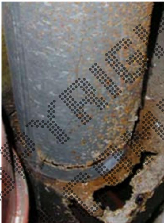
Illustrazione 20: Perforazione cassa fumi e condotto di scarico
